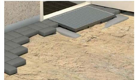
1. В случае установки поддона без подключения к системе канализации необходимо произвести выравнивание грунтового основания.
